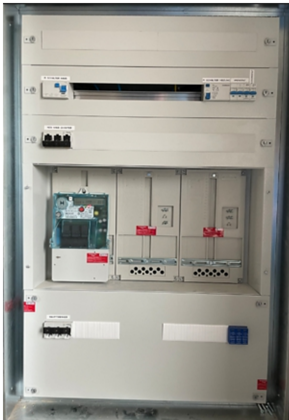
Abb.Beispiel Versiegelung Vorzählerbereich
